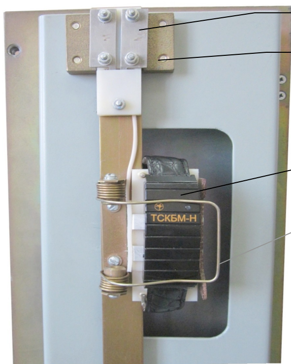
б) Крупный план установки прибора ТСКБМ-Н НКРМ.464213.006 в узел крепления ТСКБМ-Н экранированного отсека блока ТС-ТСКБМ.
